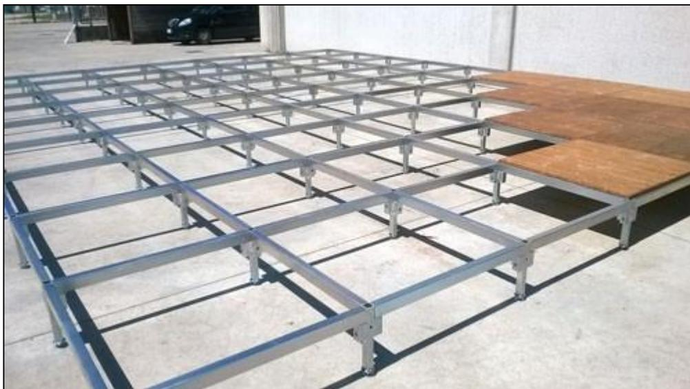
**Tipologia di struttura di sostegno della pedana**
