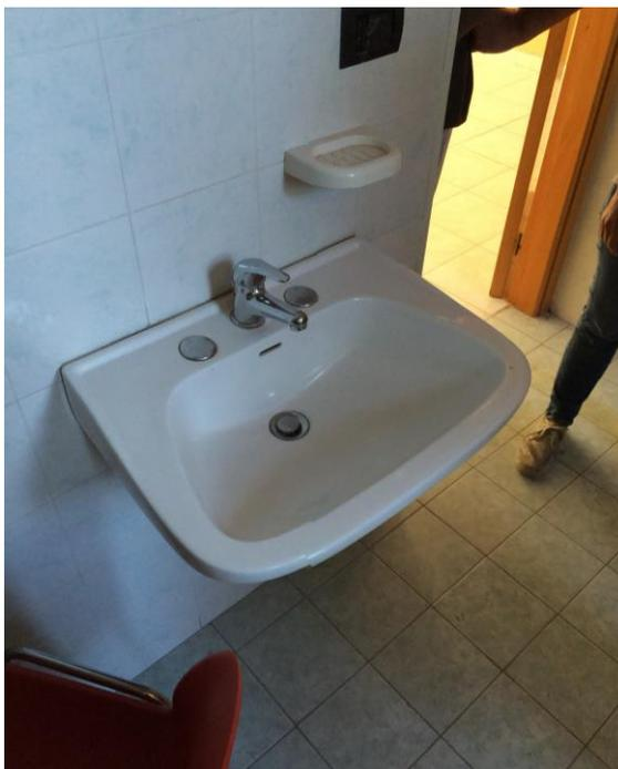
**Foto 2** : Particolare lavabo esistente da abbassare fino ad altezza idonea per bambini di tenera età.
