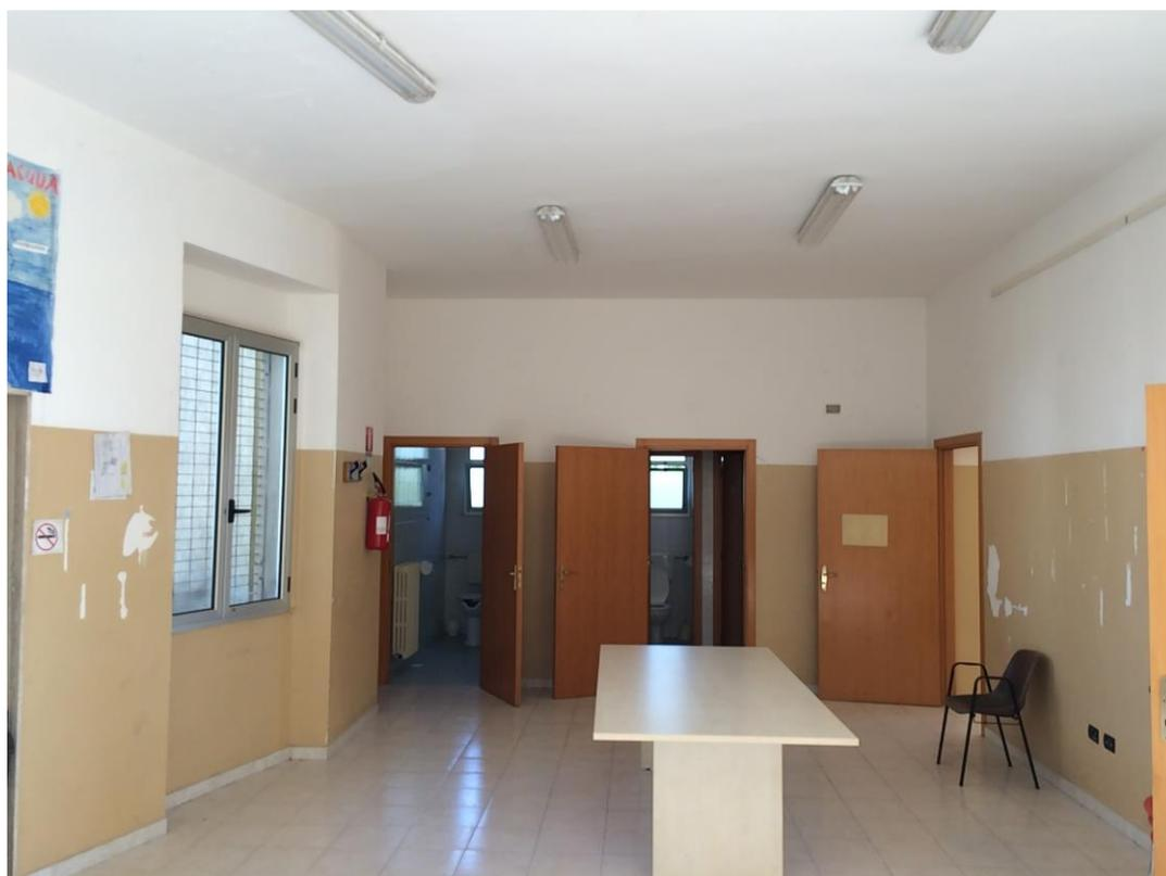
**Foto 3** : Particolare dell'ingresso oggetto dei lavori di carteggiatura e stuccatura delle parti ammalorate e pittura di tutte pareti con materiale plastico lavabile di colore giallo con tonalità a scelta della D.LL. sino all'altezza di ml. 2,00 e pittura delle murature a partire da ml 2 fino al soffitto e compreso l'intradosso dei solai con pittura traspirante di colore bianco;
