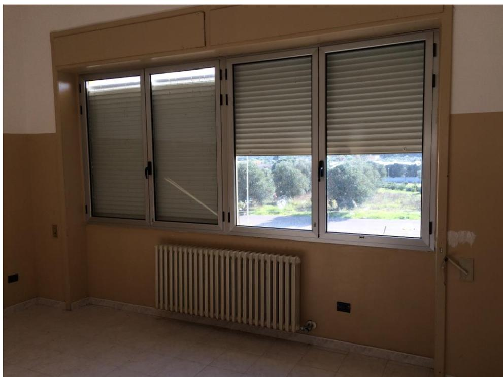
**Foto 5:** Particolare di imbotti e dei cassoni in legno delle finestre oggetto di carteggiatura degli e successiva pitturazione con idonea tinta per legno e/o smalto color legno al fine di consegnare il lavoro eseguito alla perfetta regola d'arte;
